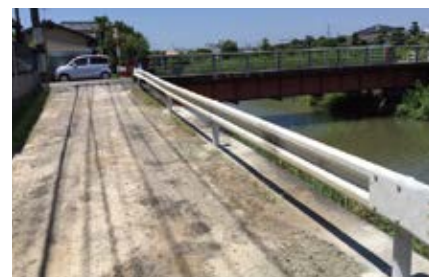
子供達が川に落ちたら大変…と指摘されていた箇所もガードレールが繋がりました。
