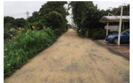
7月上旬 簡易舗装の工場が終了しました。
